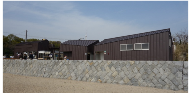
写真 22 『沙弥島西ノ浜の家』藤山哲朗+富井一級建築設計事務所 設置=坂出市
