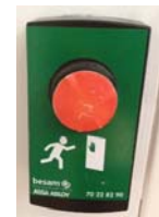
(写真7)非常ボタン
