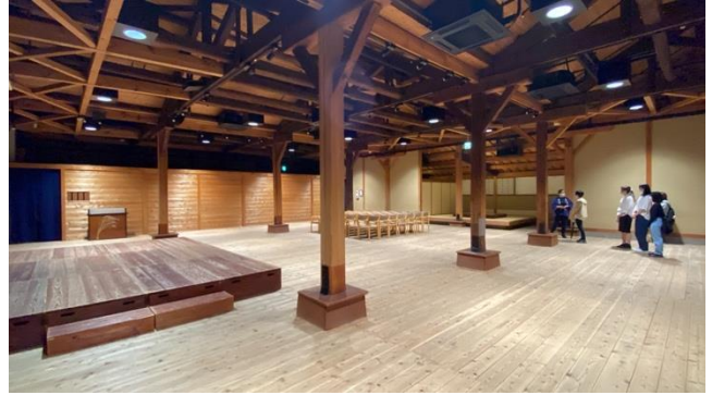
写真1 灘・酒心館における木造建築物内の素材活用事例調査。床材や調度品の一部に樽使用されていた杉材を用いている。2022年5月。筆者撮影。
