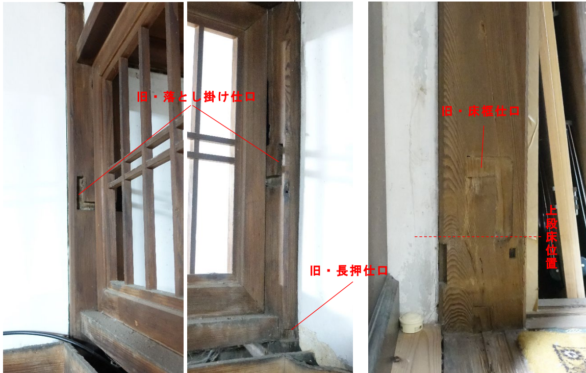
写真5 旧本陣の柱の痕跡2 左:「ほ②」上部南面西側/中:「ほ②」上部南面東側/右:「ほ②」下部南面
