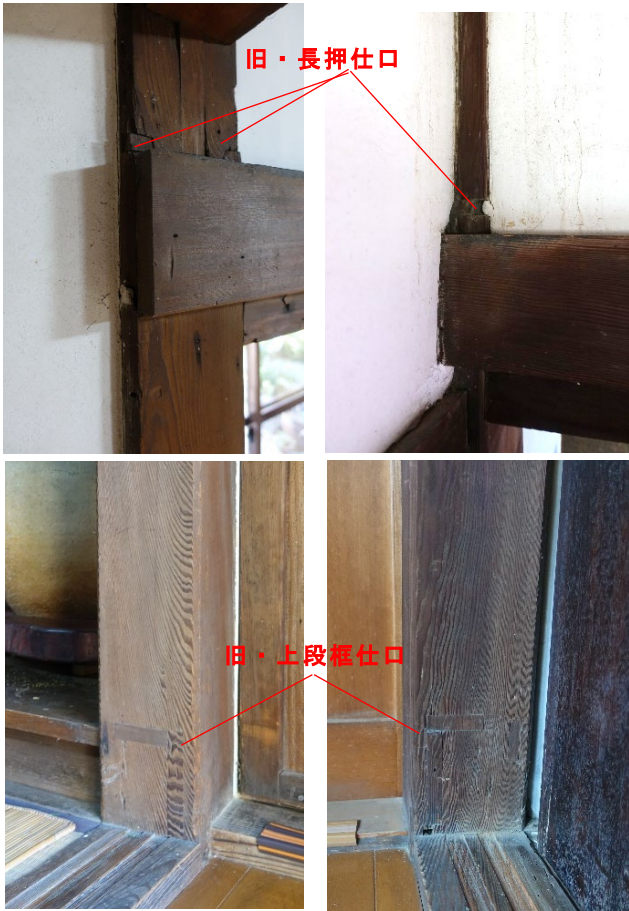
写真4 旧本陣の柱の痕跡1 左上:「ぬ⑥」上部東面/右上:「ぬ②」上部西面 左下:「ぬ⑥」下部北面/右下:「ぬ②」下部南面
