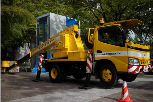
図18：外装施工のために出動した高所作業車
