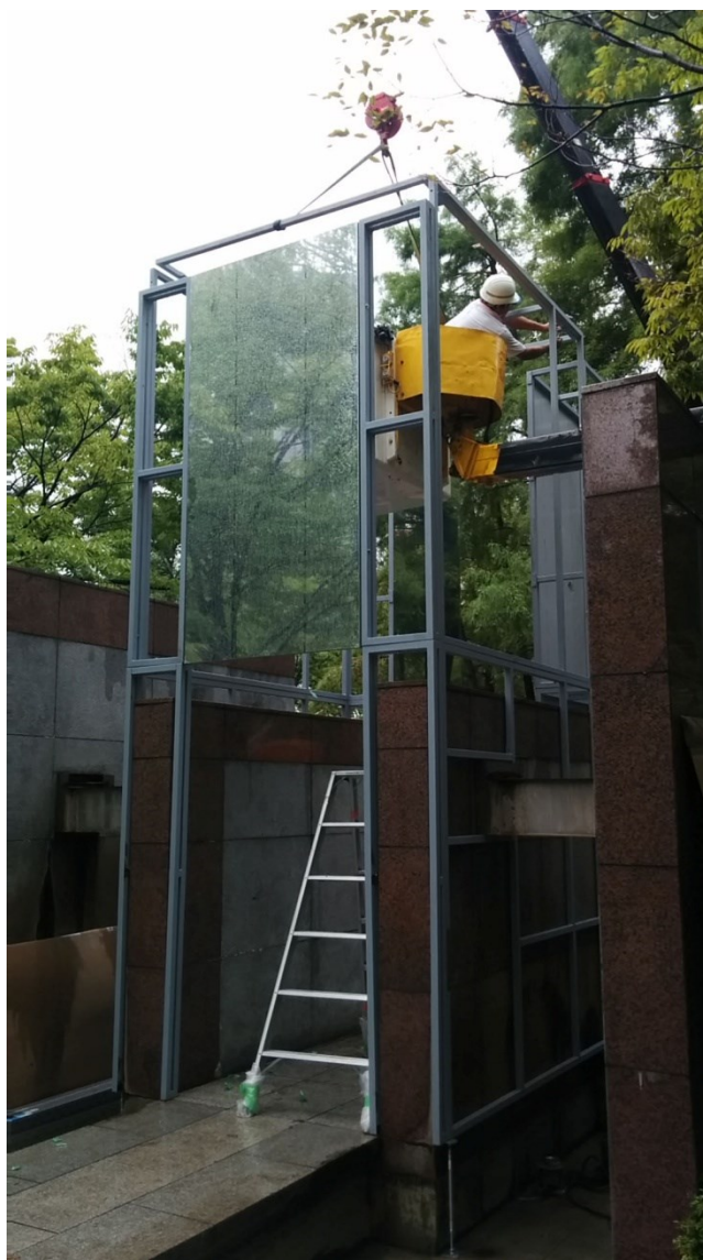
図17：わずかな隙間にゴンドラを入れる繊細な作業。
