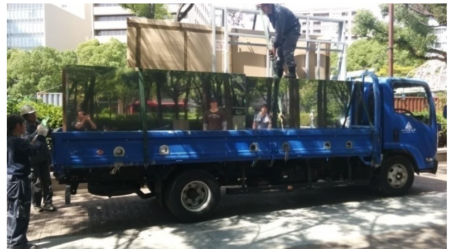
図13：現場への資材搬入。アンドの社員総出で協力いただいた。
