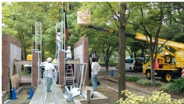
図16：高所作業車とレッカー車の高度なコンビネーション作業。公園の樹木を縫っての難しい作業である。
