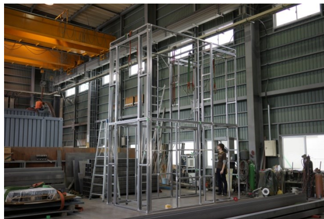
図11：株式会社アンド工場にて完成した構造体
