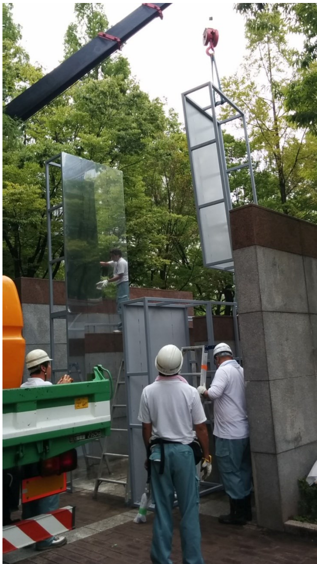
図15：神戸市道路交通局レッカー車による構造体組み立て。
