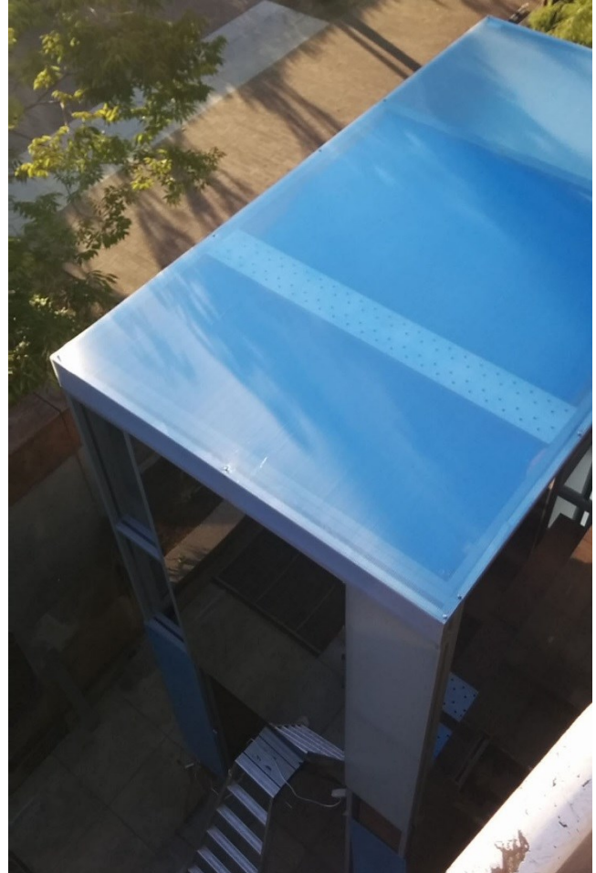
図20：設置された天井材を高所作業車、最高度から撮影。継ぎ目のない1枚板であることがわかる。
