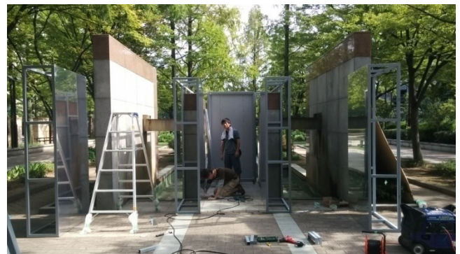
図14：低層部分の施工。各ブロックをボルト締めにより組み立てる設計である。コンテンツ共同制作者の金子准教授、スモラフスキ・ピョートル実習助手の協力を得ている。
