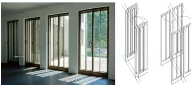
図5左) 食堂に並ぶ4つの二重ドア。右の三つのドアは全て内側に開き、左端の二重ドアは前後に開く。
