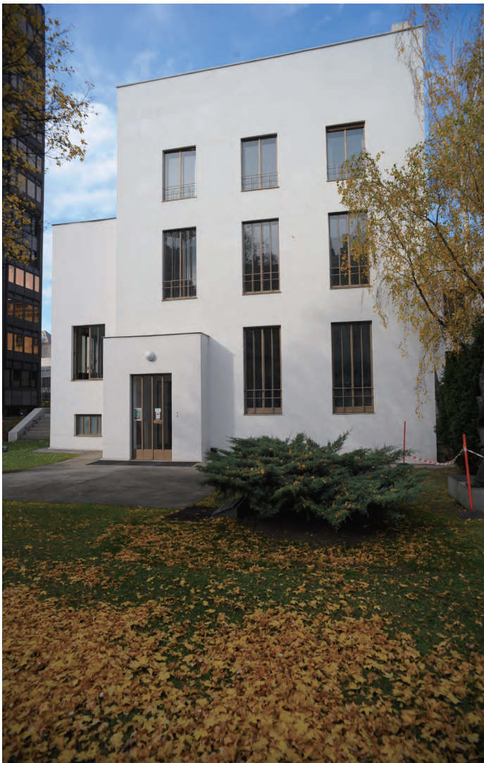
図2) ストンボロー邸 (Stonborough Villa, 1926-1928) 正面ファサード。内外ともに装飾は排除されている。外観は、縦長の開口部が均質に計画され、上部にいく程開口部の背は低くなっている。1階の床レヴェルを高く計画することにより、床には温床暖房、ペリメータゾーンには床下からの温風の吹き出し暖房装置、壁面内にはロールカーテンやブラインド、地下からカウンターウェイトを使用してせり上がる鉄製シャッター等の環境制御装置が組み込まれている。姉マルガレーテ・ストンボローのために、ヴィトゲンシュタインがその生涯で唯一設計をおこなった建築である。(撮影: 小山明 Akira Koyama)
