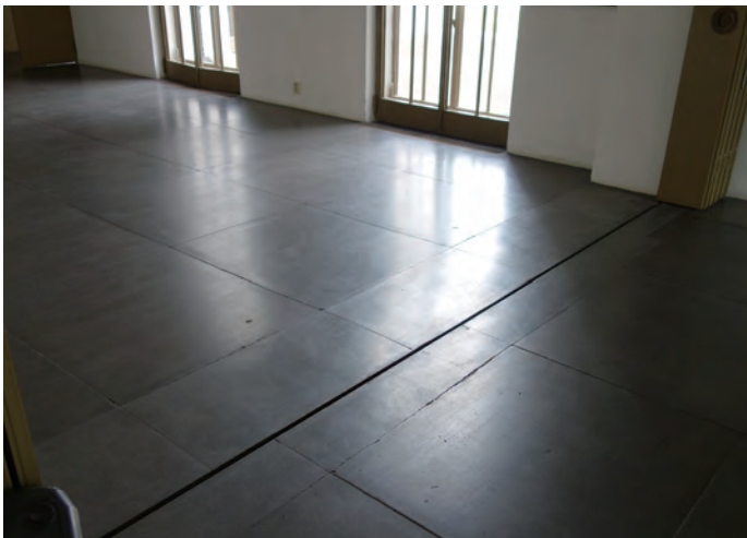
図 12) 改造によって取り除かれた居間とサロンを接続するドアが設置されていた壁面。現在は、床のタイルの目地の差異において、2つの部屋であったことが確認することができる。
