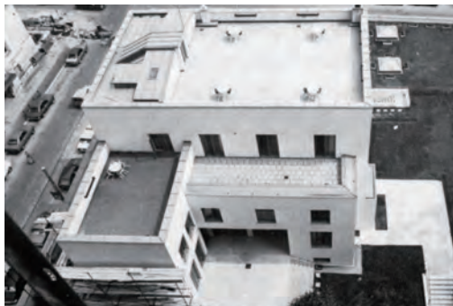
図3) 高層建築からストンボロー邸の屋上を見る。右の通りはパークガッセ、左の通りがクントマンガッセ。
