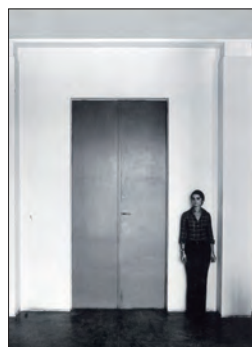
図 26) 磯崎新が問題とするサロン入口のドア。鉄製のフラッシュ構造で作られ、ディテールを見せないフラットな仕上がりとなっている。
