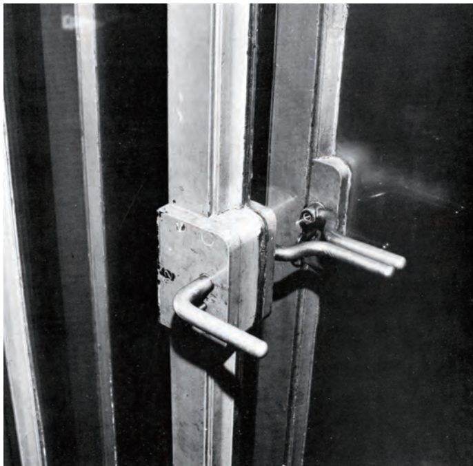
図5) ヴィトゲンシュタインが神経質なまでにこだわりをみせたドアの鍵穴。ドアハンドルおよび鍵穴の形状は、ドアの表と裏で異なっている。
