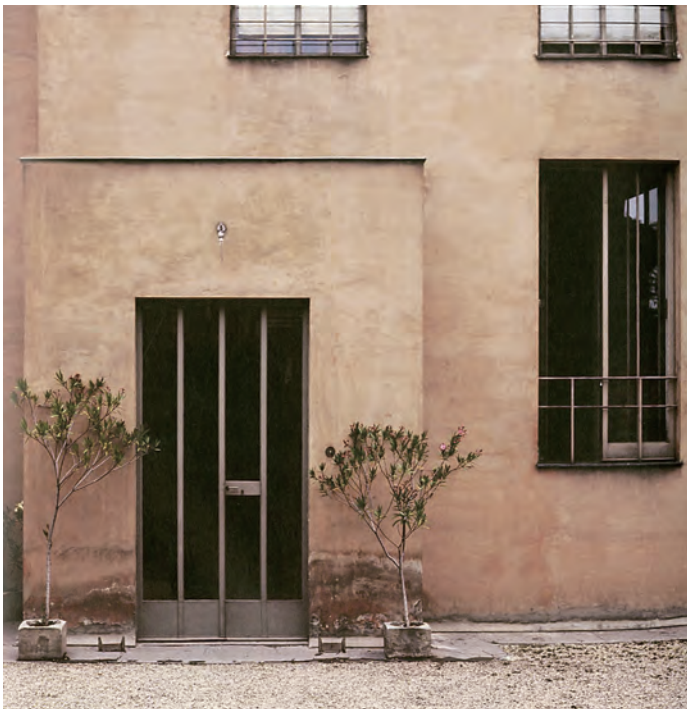
図9) ストンボロー邸玄関。改修前の外壁はクリーム色の塗料で覆われていたが、現在は、白色で塗り直されている。また開口部のドアも同様に当時の色とは異なっている。玄関のドアの上部に取り付けられている照明も現在のものとは異なる。
