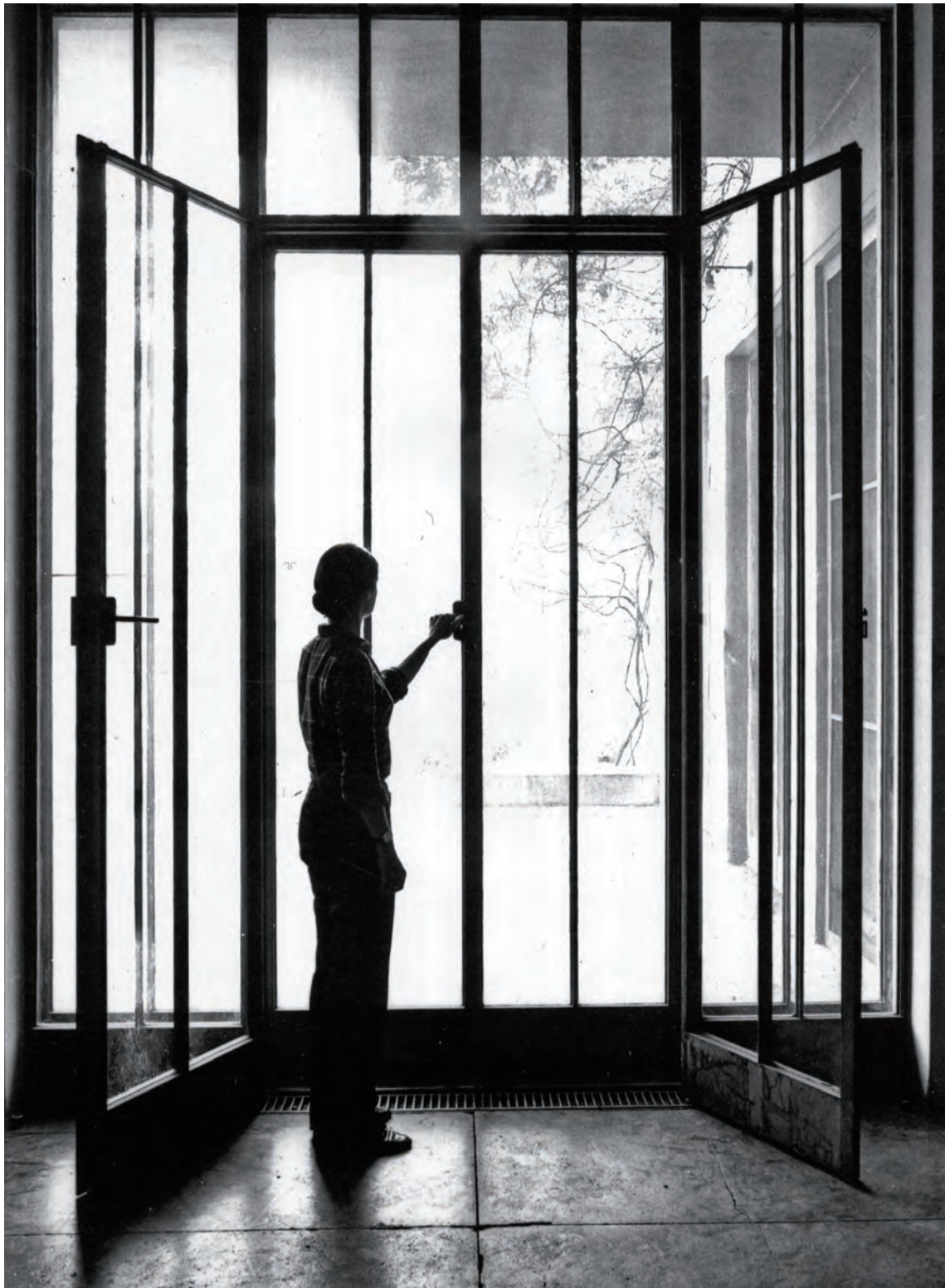
図 11) ホールからテラスへ接続する二重ドア。 ドアハンドルの位置は、ドアを開けようとする女性 の顔付近の高さに組み付けられている。また二 重ドアある一枚のドアを開くだけで、人間が通り 抜けることが可能な多きであることがわかる。
