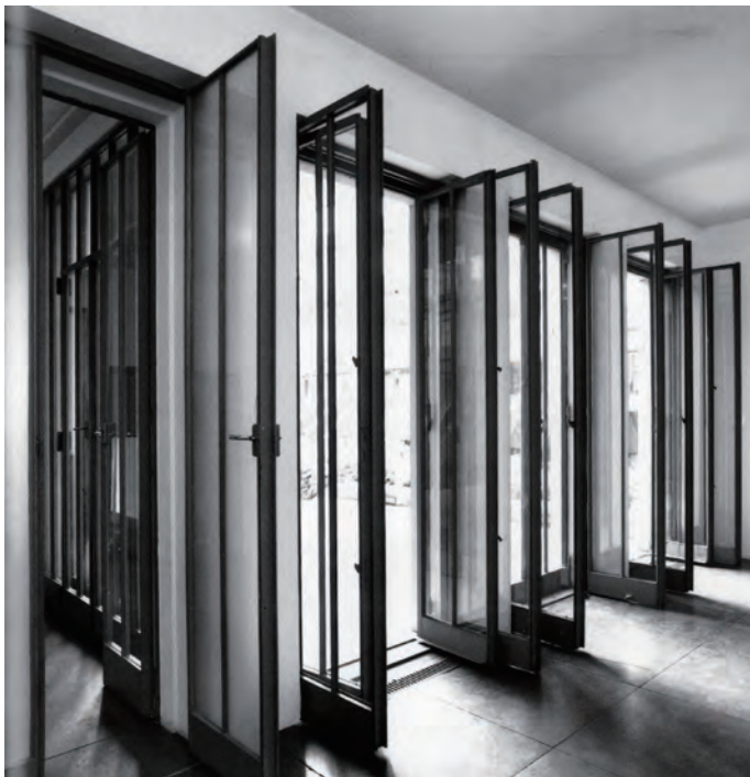
図7) 食堂に4つ並ぶ二重ドアを全開にした状態。その内右の3つの二重ドアは、全て内側に開きテラスに接続する。左の二重ドアは、前後に開き、ホールに接続する。
