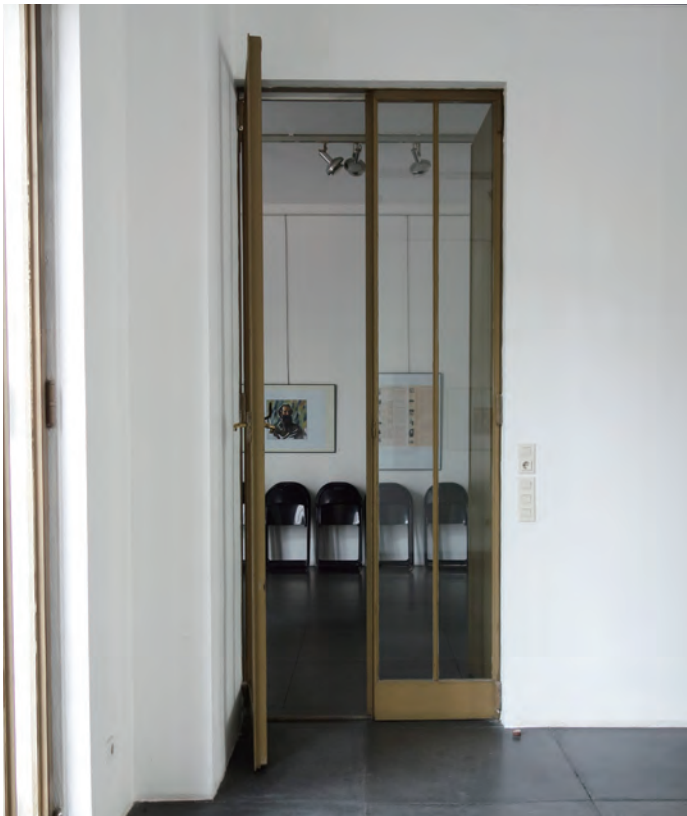
図10) サロンと夫人居間を接続する鉄製・ガラス製の二重ドア。夫人居間側のドアは左手用のハンドルがくみ付けられている。ドアハンドルおよびドアストッパーによって、より90度以上開くことは物理的に困難である。
