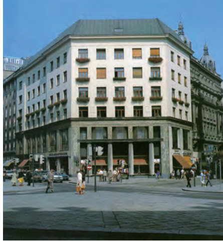
図 27) ミハエル広場の建築 (Haus aud dem Michaelerplatz)。またの名称を ロースハウ (Looshaus)。この建築のエントランス部分には、古典主義の建築から引用したとされる、大理石の列柱が配置されている。その一方、上層部のファサードは装飾が取り除かれ、ストンボロー邸の外観との類似性が指摘されている。
