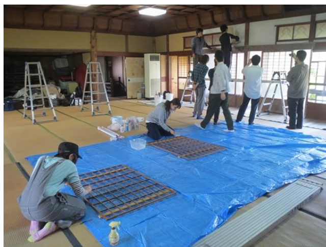
図2 旅亭文市楼の改修(壁塗り・障子貼り)作業の様子
