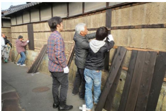
図1 小河家住宅の改修(壁塗り・障子貼り)作業の様子
