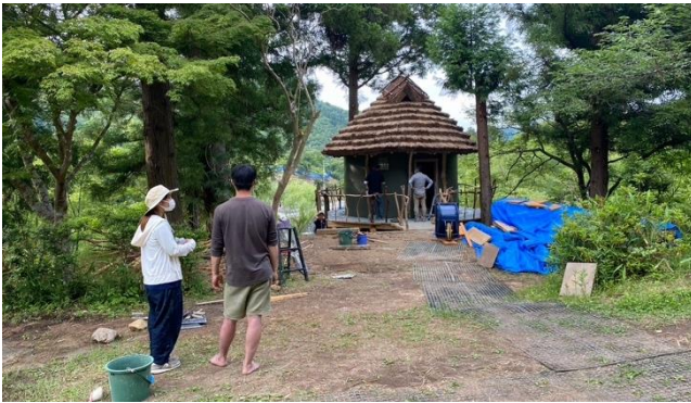
図7 地域から派生した伐採材(杉)を用いた休憩スペースの制作。自然木の形状を利用し、自然素材のみで制作されている。(撮影日:2021年6月6日、撮影者:筆者)
