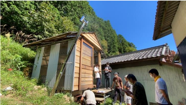
図8 敷地内に建てられた蒸留施設、壁板には地域の間伐材を利用。アロマオイルを抽出するための蒸留器が設置されている。(撮影日:2021年9月27日、撮影者:筆者)
