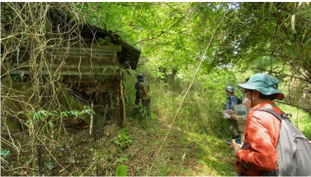
図2 あいな里山公園未開園地区における残存施設調査。1990年代初頭まで使用されていた。(撮影日: 2021年5月22日、撮影者: 筆者)
