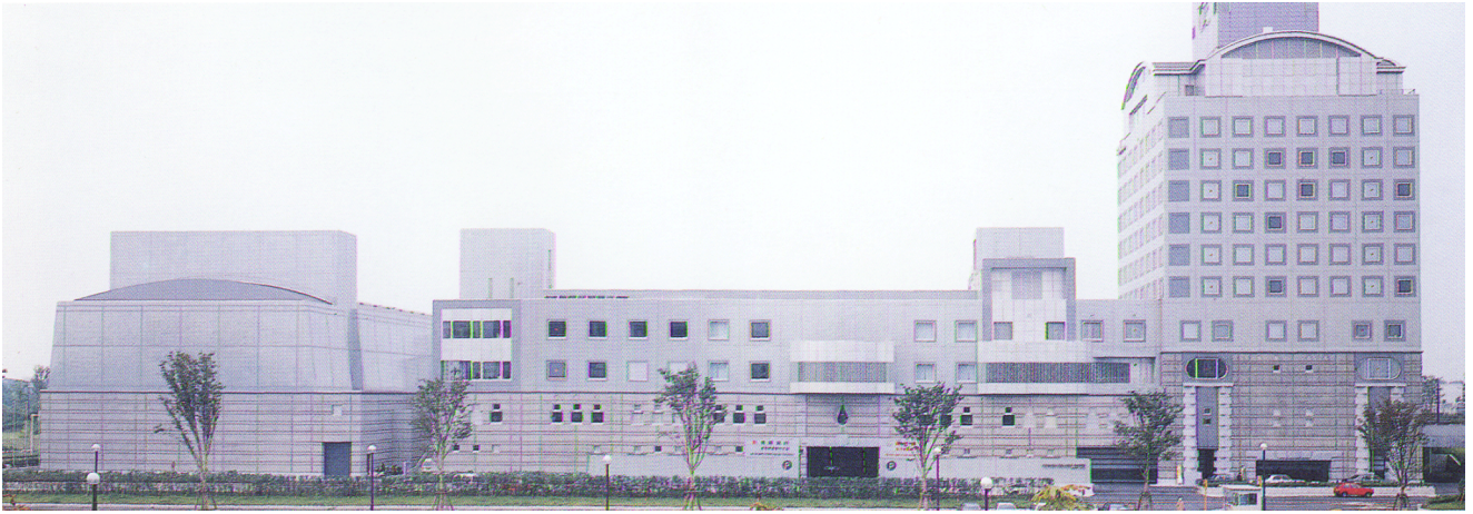
図 13) つくばセンタービル 東側全景
