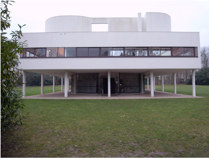
図 11) 自動車の回転半径に合わせて計画された1階玄関廻りのガラス外壁
