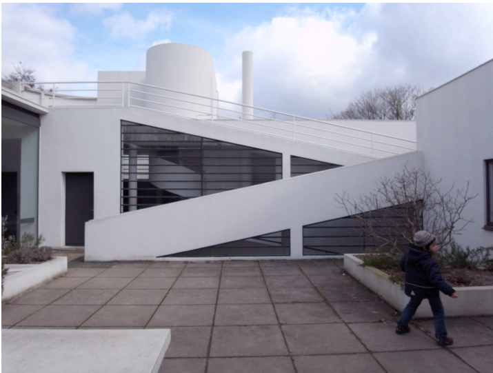
図 12) 装飾を排除する一方で、機械美を持つ客船を意識したデザイン
